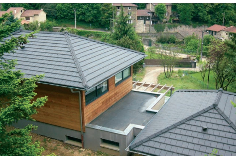
▲ Vue sur les toitures
