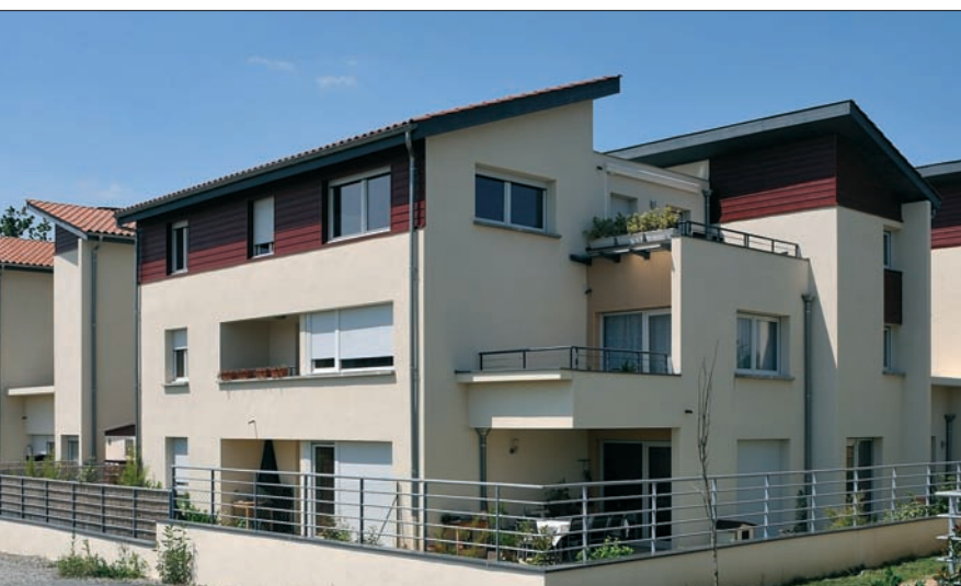
▲ Les logements bénéficient tous d'un espace extérieur : terrasse ou jardin privatif
