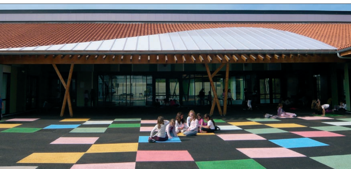
▲ Préau / Salle Polyvalente, les ondulations en toiture évoquent l'océan et la dune du Pilat
