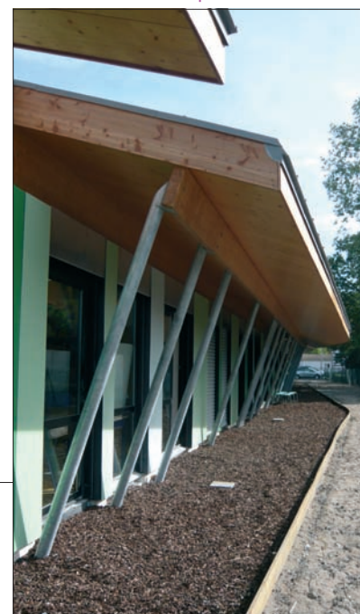
▼ Débords de toiture : protection solaire
