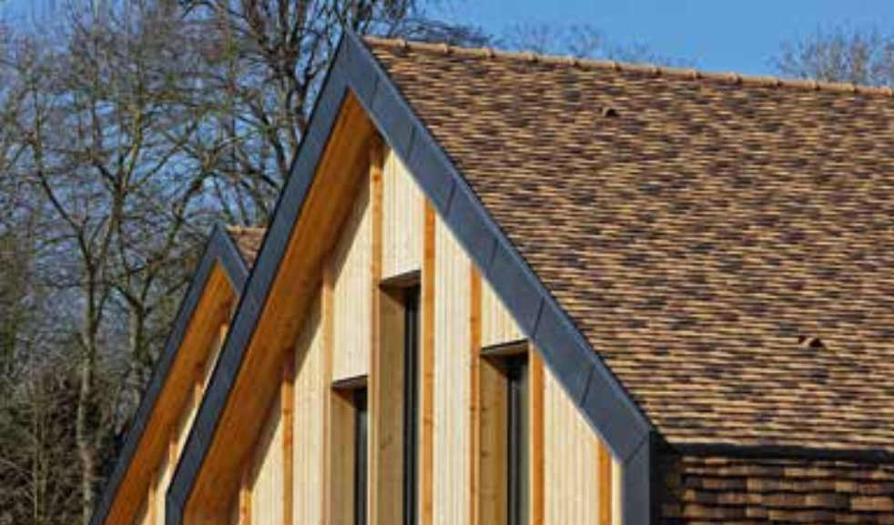
▲ Tuile, zinc et bois : les 3 composants de l'enveloppe.
