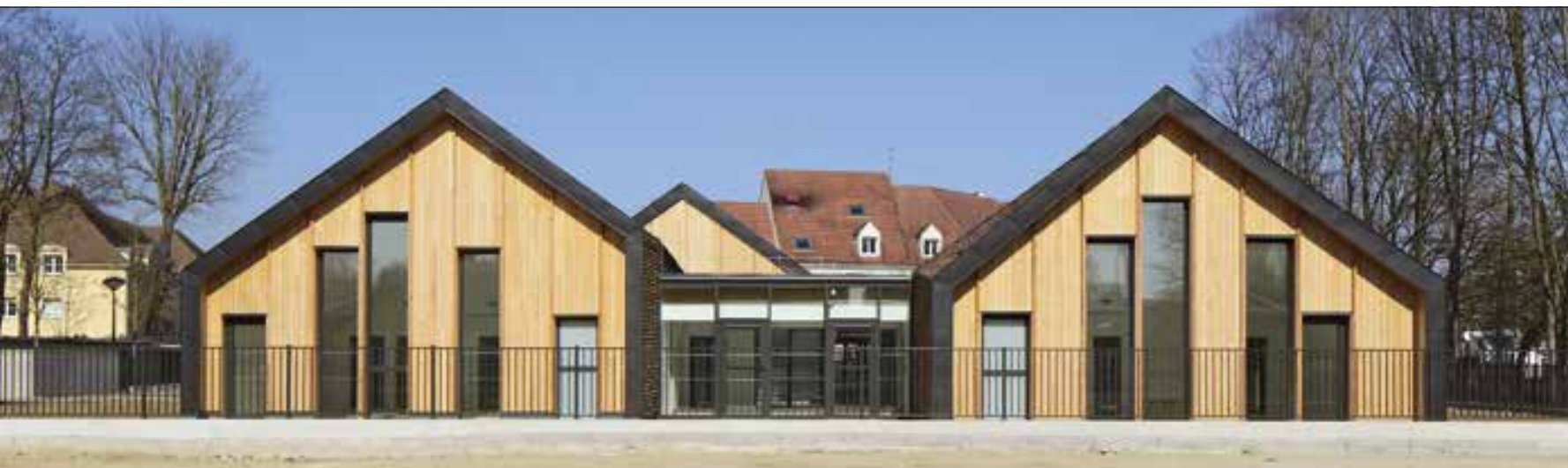
▲ Vue de la façade sud. Les apports lumineux sont gérés par un dispositif de stores extérieurs en réseau sur toutes les surfaces vitrées du bâtiment.
