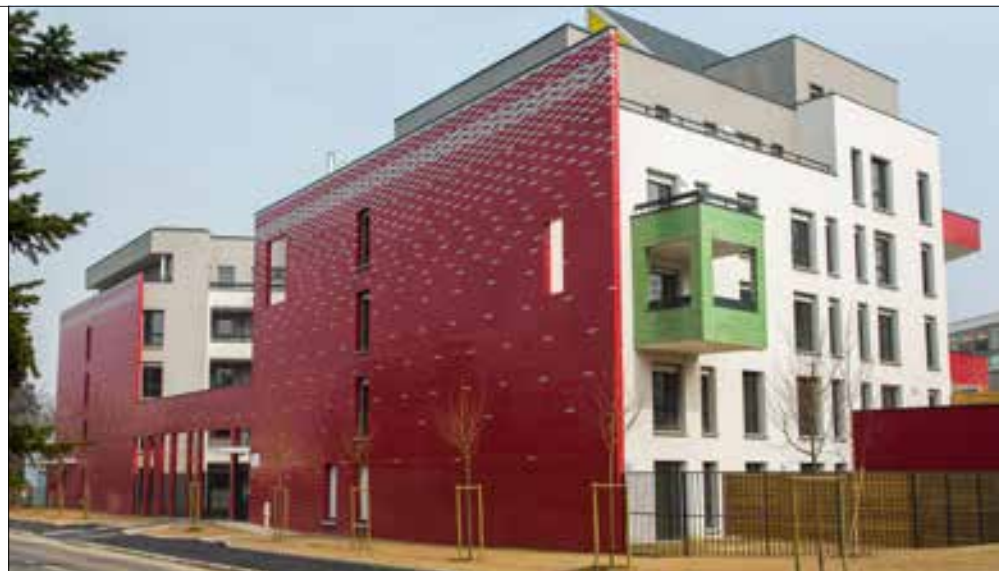
▲ Rue du jeu de paume : protection et ouvertures.
