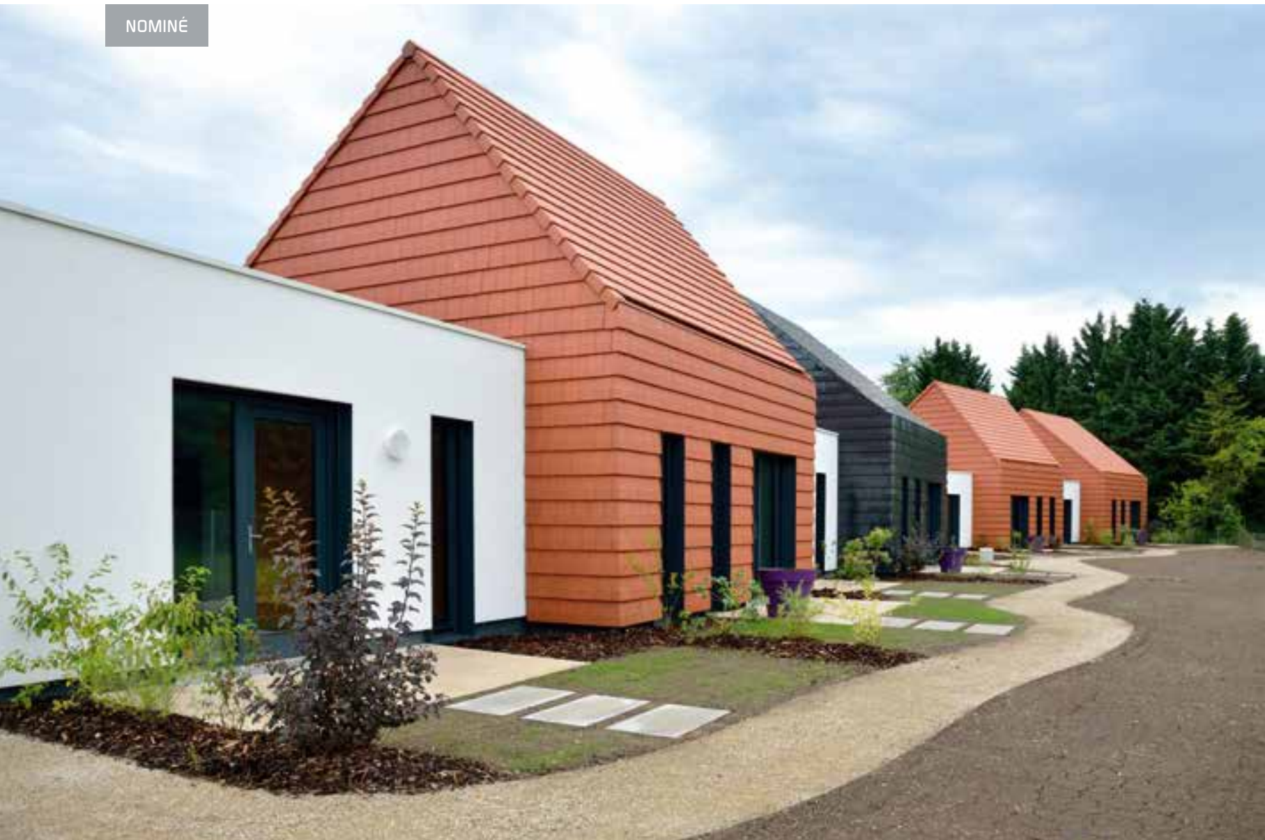
▲ Une rue intérieure ponctuée de maisonnettes.
