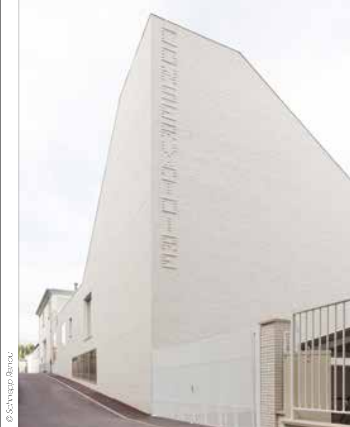
▲ Signalétique du conservatoire : briques de même tonalité décalées de 1-2 cm.
