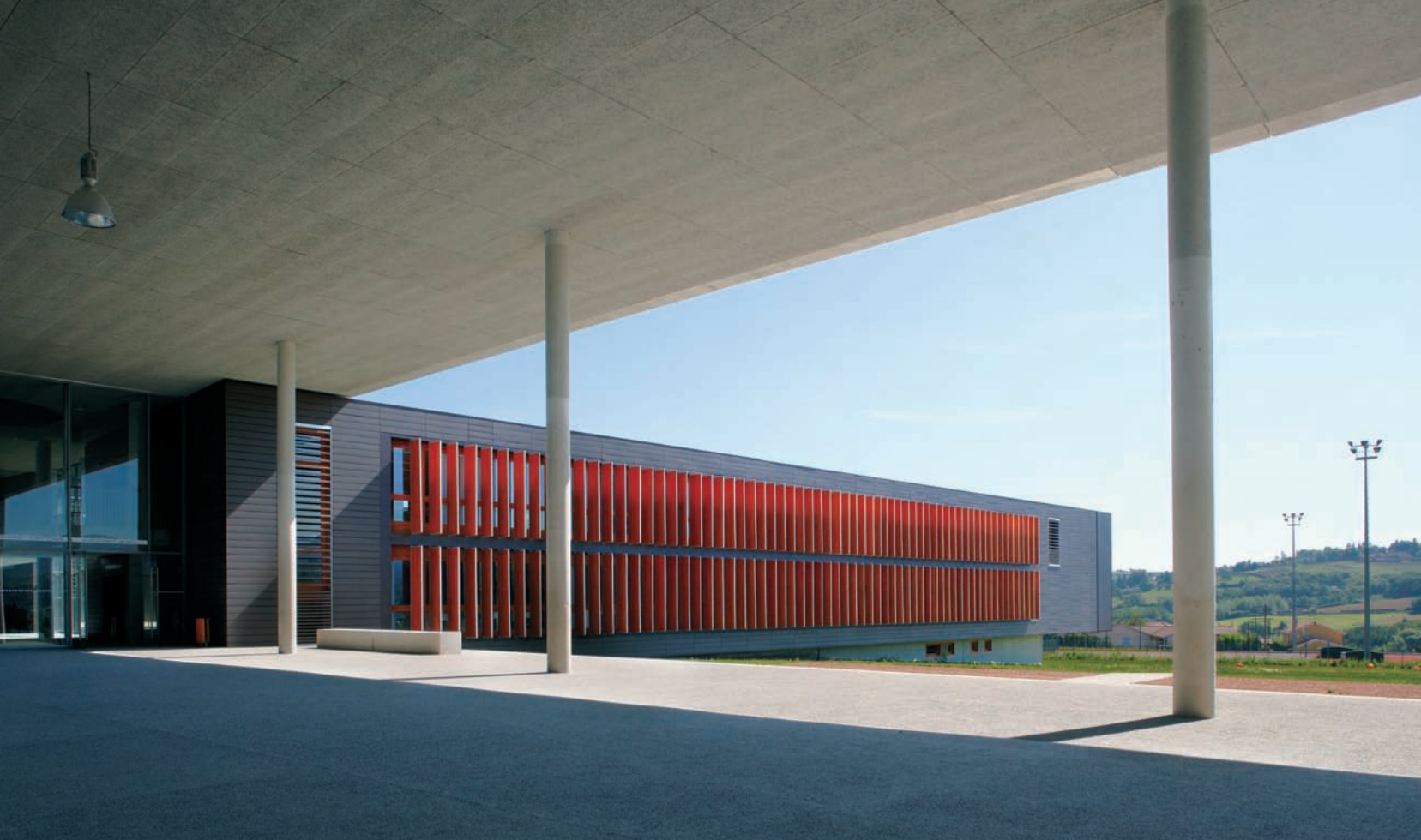
▲ La façade sud de l'aile d'enseignement scientifique vue depuis le préau. Les bardeaux de terre cuite ébène se marient avec les brise-soleil de mélèze lazuré.
